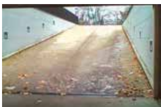
Tiefgarageneinfahrt mit Rampenheizung
