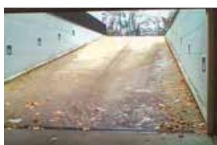
Tiefgarageneinfahrt mit Rampenheizung
