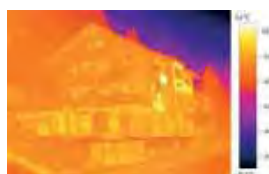
Wärmebild ohne testo ScaleAssist
