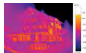
Wärmebild mit testo ScaleAssist
